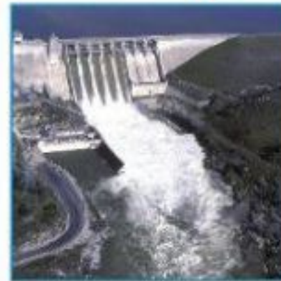
طاقة المياه المندفعة من السد تتحوّل إلى طاقة كهربائية.
