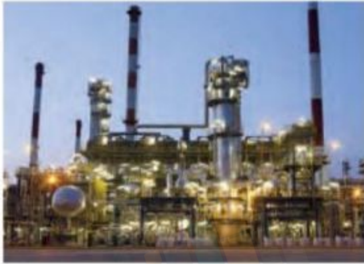
محطة توليد الكهرباء في الجبيل
